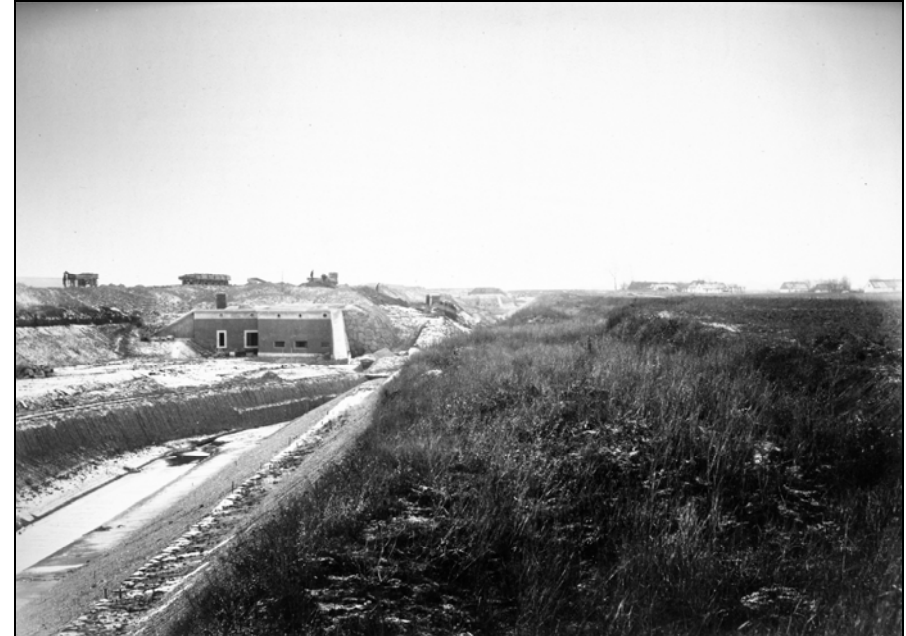
Fra byggeriet af "Vestvolden" i 1888-1892. Den udstrakte fæstningslinje lå mellem Tunestillingen og Københavns bymidte. Statens Forsvarshistoriske Museum.
