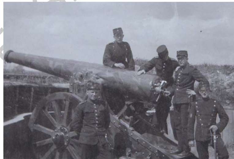
En 15 cm stållkanon model 1892 fra fæstningsartilleriet, her på Tinghøjbatteriet under sikringsstyrken. Maksimal rækkevidde 6,5 km. Da pjecen ikke havde rekylmekanisme, skulle den bringes i stilling og rettes efter hvert skud. Rigsarkivet.
